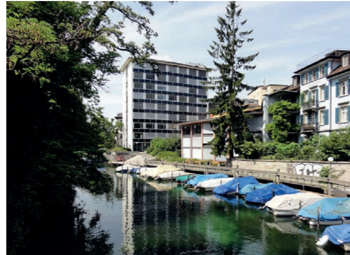
Umbau Hochhaus Bastel, Zürich
